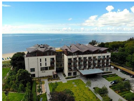
Upstalsboom Wellness Resort Südstrand Luftaufnahme
